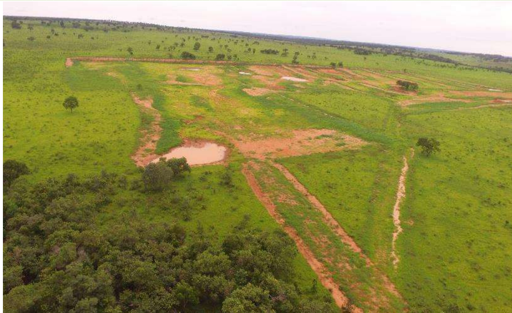
Figura 11. Depois – Imagem aérea da área de Empréstimo de Argila. PRADE - PCH Verde 4, janeiro de 2020.
