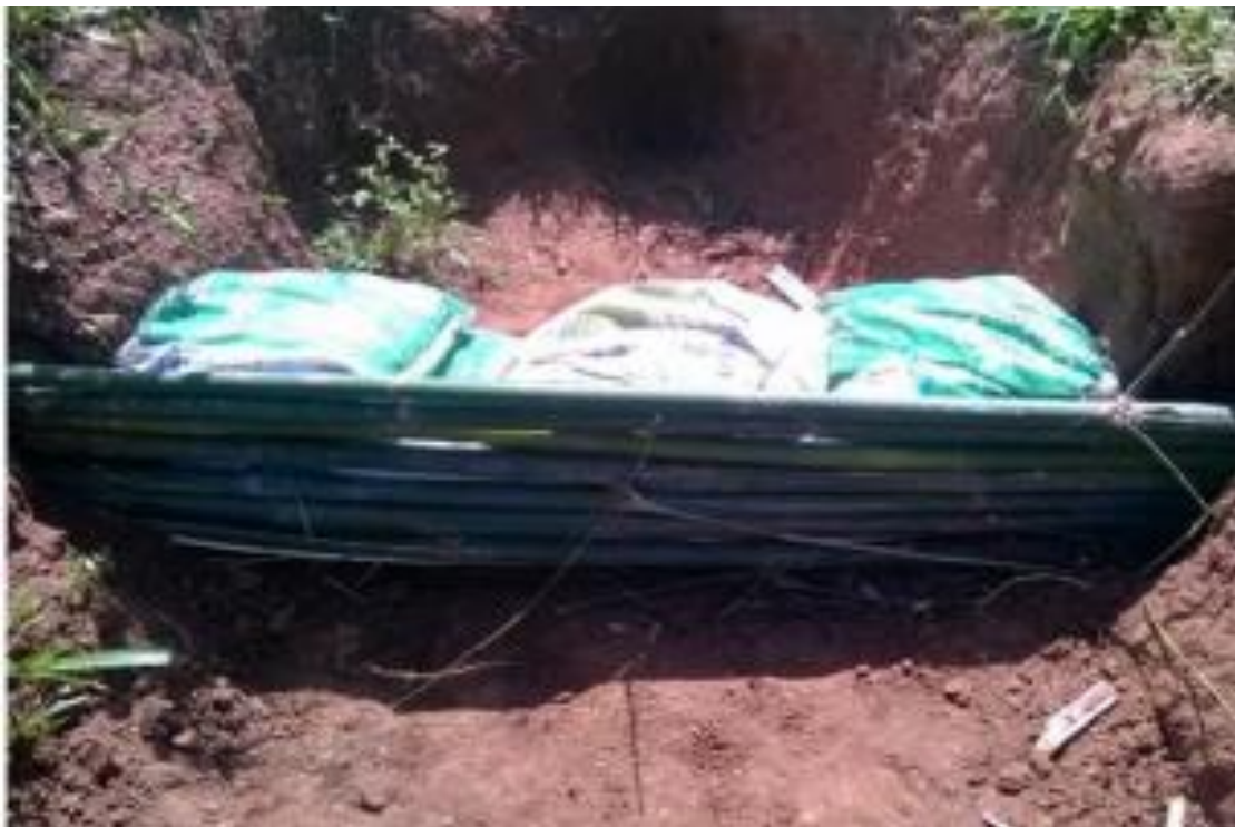
Figura 5 – Exemplo de utilização de paliçada de bambu com sacos de rafia contendo terra.
