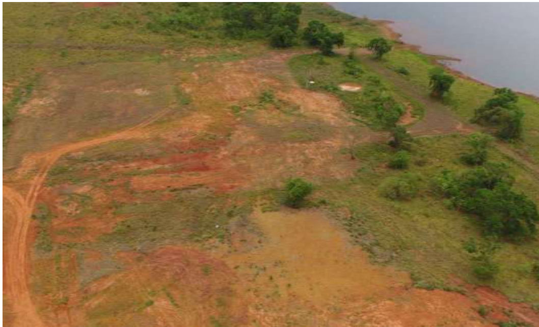
Figura 3. Antes – Imagens obtidas com Drone da Central de Concreto, Laboratório de Concreto e Solo e Pré-montagem, totalmente desmobilizada. PRADE - PCH Verde 4, outubro de 2019.
