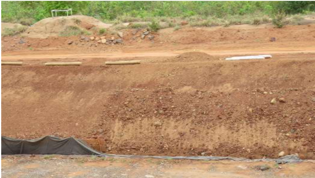
Figura 19. Antes – Área Acesso provisório à jusante (ME). PRADE - PCH Verde 4, outubro de 2019.
