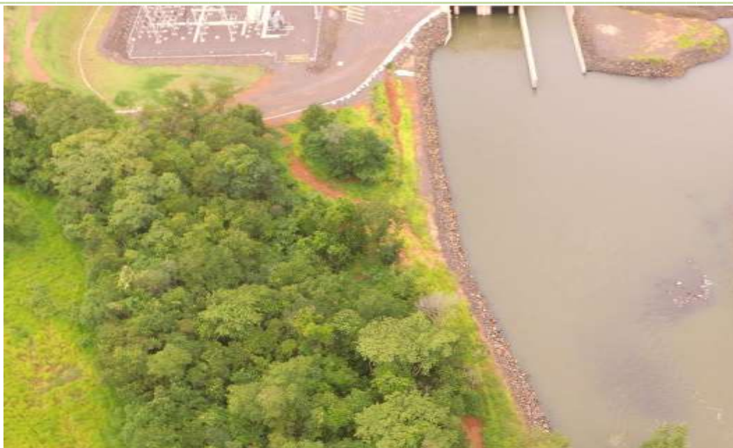
Figura 13. Depois – Área próxima a casas de força e subestação. PRADE - PCH Verde 4, janeiro de 2020.
