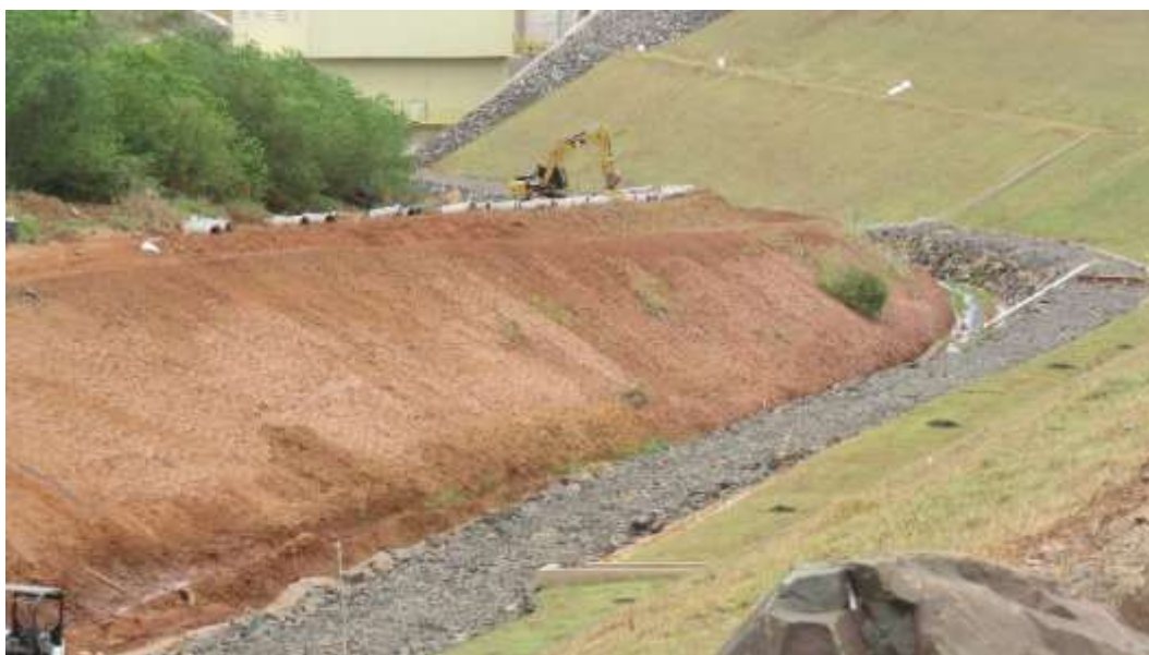
Figura 18. Antes – Área Acesso provisório à jusante (ME). PRADE - PCH Verde 4, outubro de 2019.
