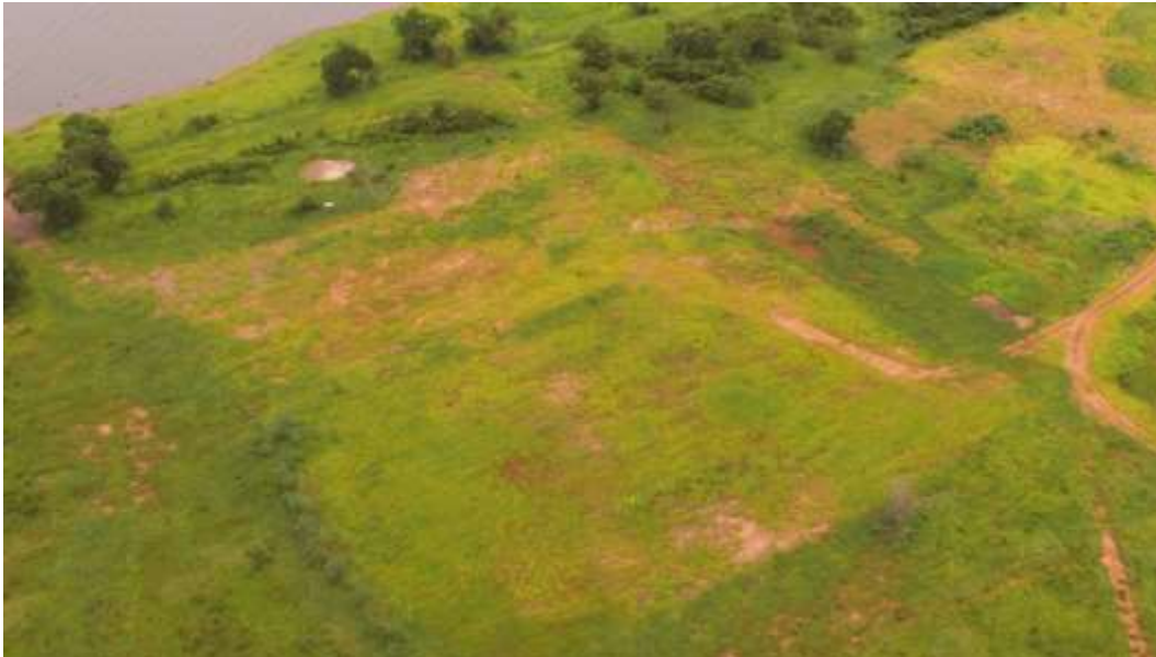
Figura 4. Depois – Imagens obtidas com Drone da Central de Concreto, Laboratório de Concreto e Solo e Pré-montagem. PRADE - PCH Verde 4, janeiro de 2020.
