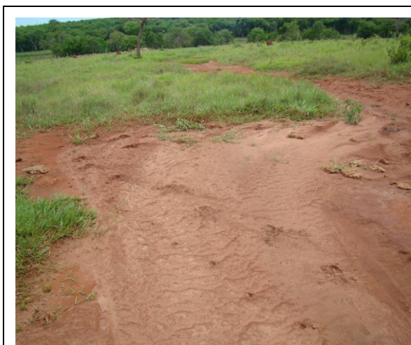
Foto - 5. Vista parcial do processo erosivo PE5 na sua parte superior, já fora da APP.
