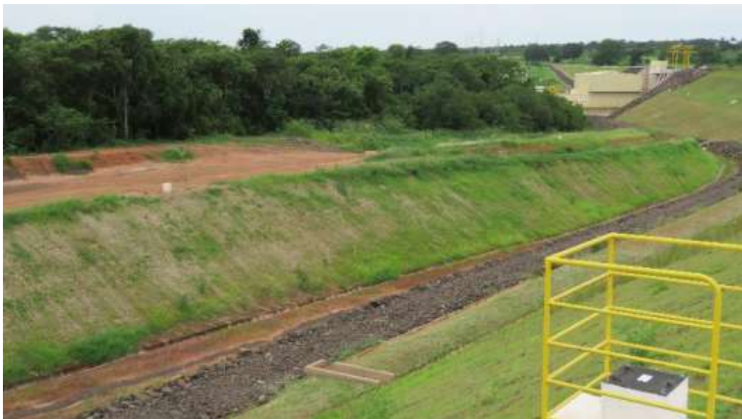
Figura 20. Depois – Área Acesso provisório à jusante (ME). PRADE - PCH Verde 4, janeiro de 2020.
