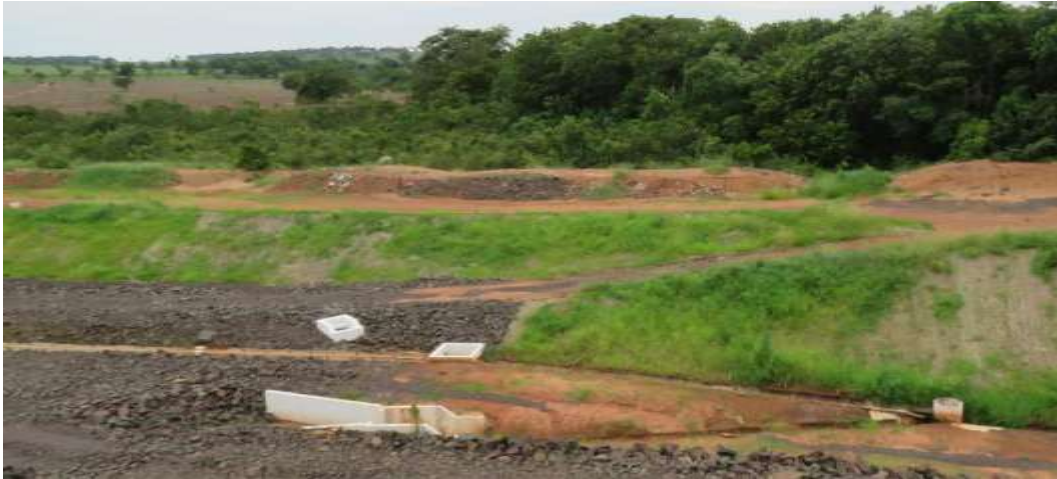
Figura 21. Depois – Área Acesso provisório à jusante (ME). PRADE - PCH Verde 4, janeiro de 2020.
