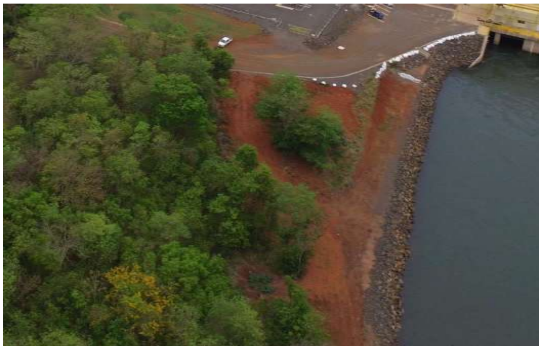
Figura 12. Ante – Área próxima a casa de força e subestação. PRADE - PCH Verde 4, outubro de 2019.
