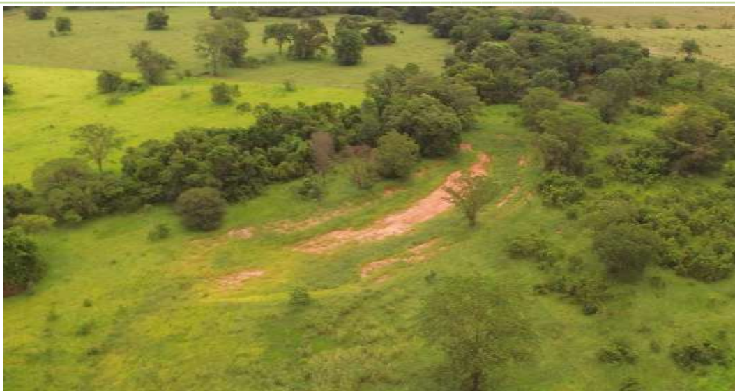
Figura 17. Depois – Área Jusante do barramento (área ampliada do canteiro). PRADE - PCH Verde 4, janeiro de 2020.
